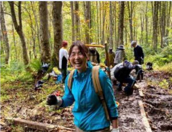
遊歩道側溝整備
